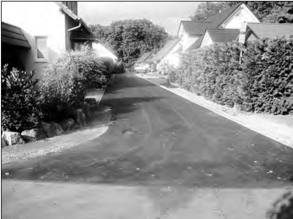
Die Straßenbaumaßnahme am Lindenhof befindet sich kurz vor der Fertigstellung.
