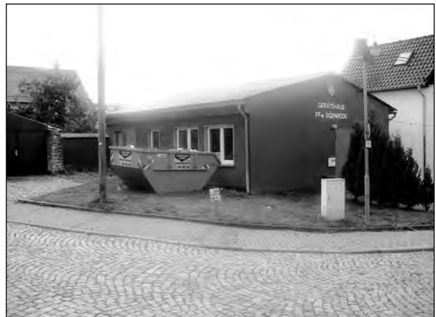
Die Umbau- und Sanierungsarbeiten am Feuerwehrgerätehaus haben begonnen.
