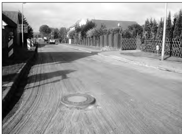
Durch das Thüringer Straßenbauamt wurden Straßenreparaturarbeiten im Bereich "Zur Vorstadt" durchgeführt.
